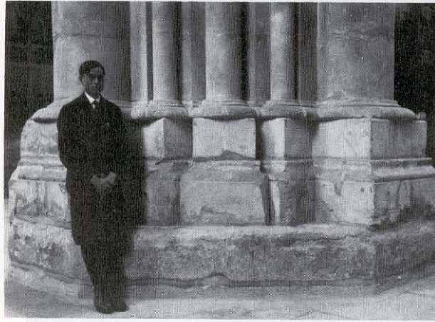
Abb. 23 Reims, Kathedrale, westlichster Langhauspfeiler
