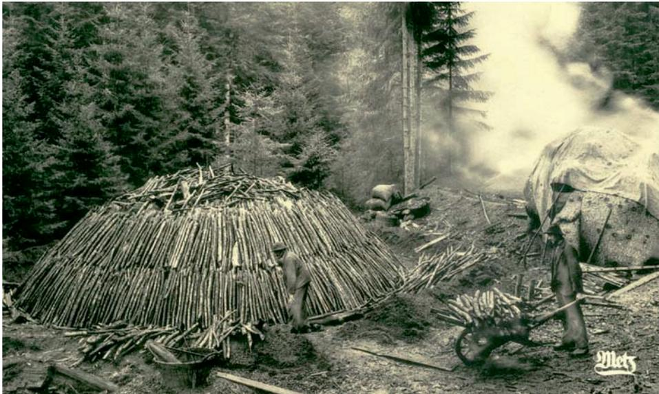
**Abb. 13.** Holzkohleproduktion in stehenden Rundmeilern. Meiler kurz vor dem Abdecken. „S’rechte ufsetze isch’s wichtigst“: Auf einer kreisrunden Verebnung von 8 bis 12 m Durchmesser wurde das Kohlholz aufrecht stehend in zwei bis drei Stockwerken halbkugelförmig zusammengestellt. Im Hintergrund rechts ein brennender Meiler (Fotografie: © Verlag Metz, Tübingen 1905).
